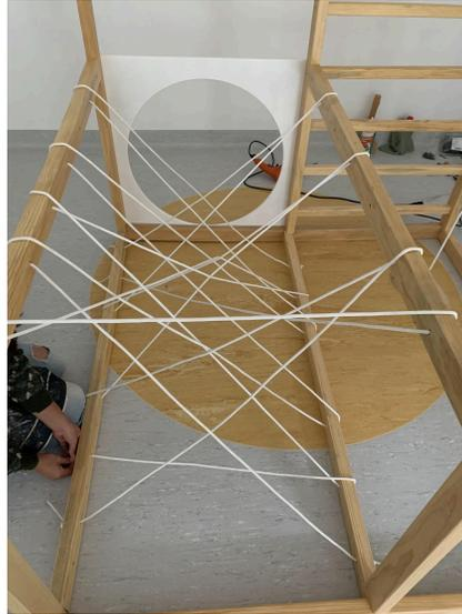
Para el puente colgante, toma las cuerdas que ya vienen con los escalones y pasándolos por los orificios previamente perforados en las vigas, haz un nudo simple para que se fijen.
